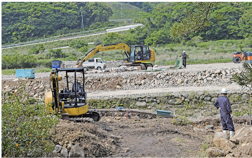
水田と水路に土砂を搬入
