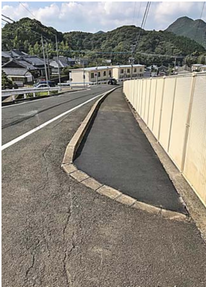
里山の歩道改修できました
