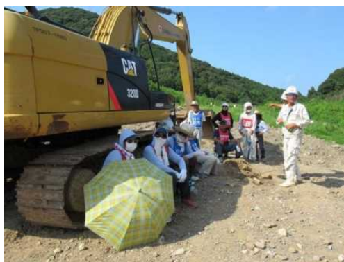
工事現場。ブログ「石木川まもり隊」より
