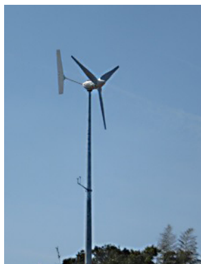
田平町久吹ダム近くの小型風力発電
