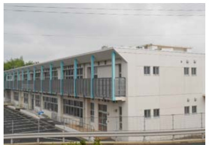
太陽光パネルが着く御厨小学校
