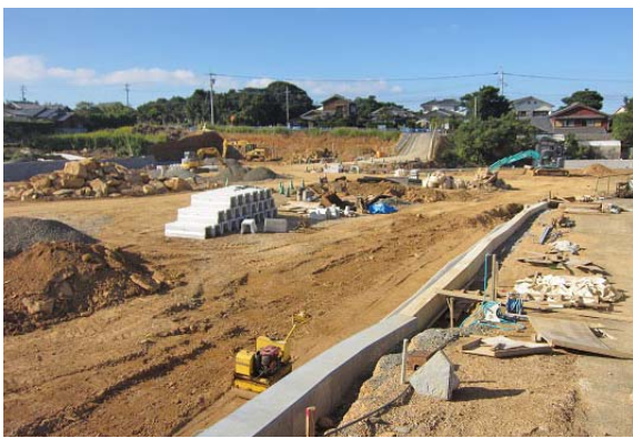
大型店の建設工事
