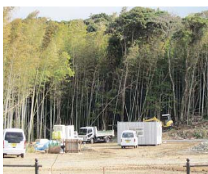
岩の上町で消防庁舎の建設がすすんでいます
