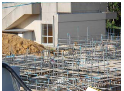
8月2日 星鹿小学校校舎改築工事が進んでいます。学校は夏休み中ですが、工事は着々と進んでいます。
