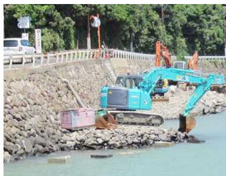
工事中の市道亀岡循環線
