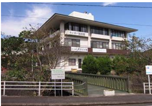
4000万円で解体される離島センター
