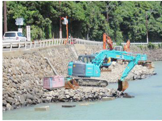
工事中の市道亀岡循環線
