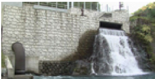
橋原川にあるわずか6mの落差を利用して、発電出力53kwの小水力発電を行っています。(橋原町のホームページより)
