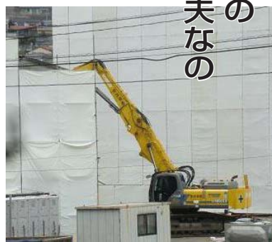
SSK白岳工場の解体作業
