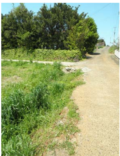
改修場所は、平本宅前（写真上）と田崎宅前
