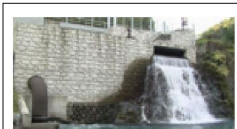
檮原川にあるわずか6mの落差を利用して、発電出力53kwの小水力発電を行っています。
