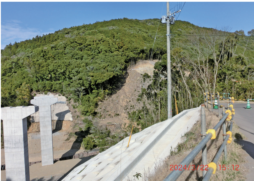
石木ダム付替道路工事の現場
